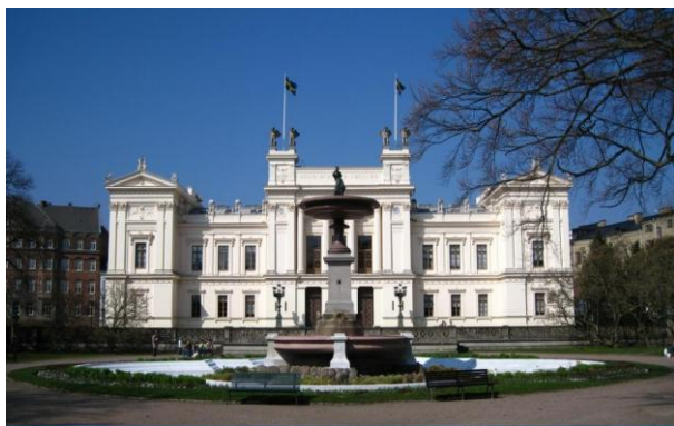
写真-1 ルンド大学 大学本部
